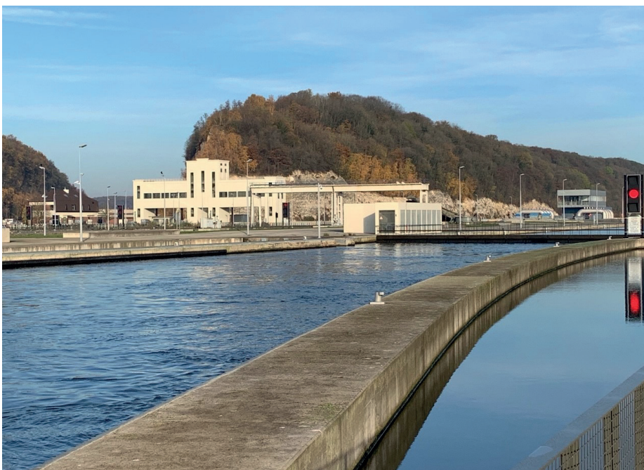
Figure 3 The lock at Ternaaien.
